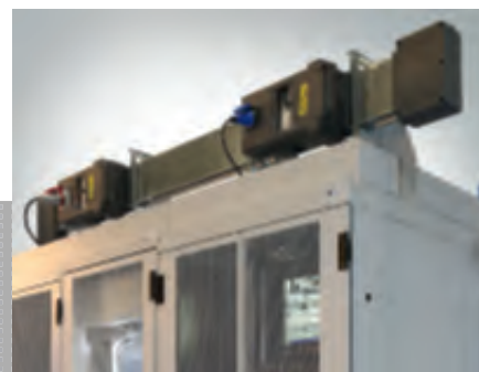
2 Boîtes de dérivation Cold Corridor → VOIR P. 51
