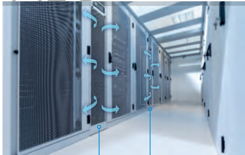
Exemple de système H 2 O dans un Cold Corridor
