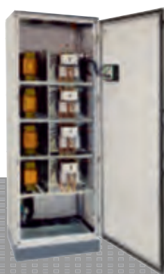
4 Batteries de condensateur → VOIR P. 17
