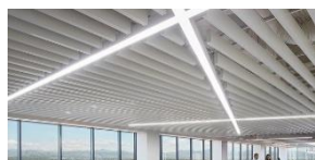
Gérer et optimiser l'éclairage
